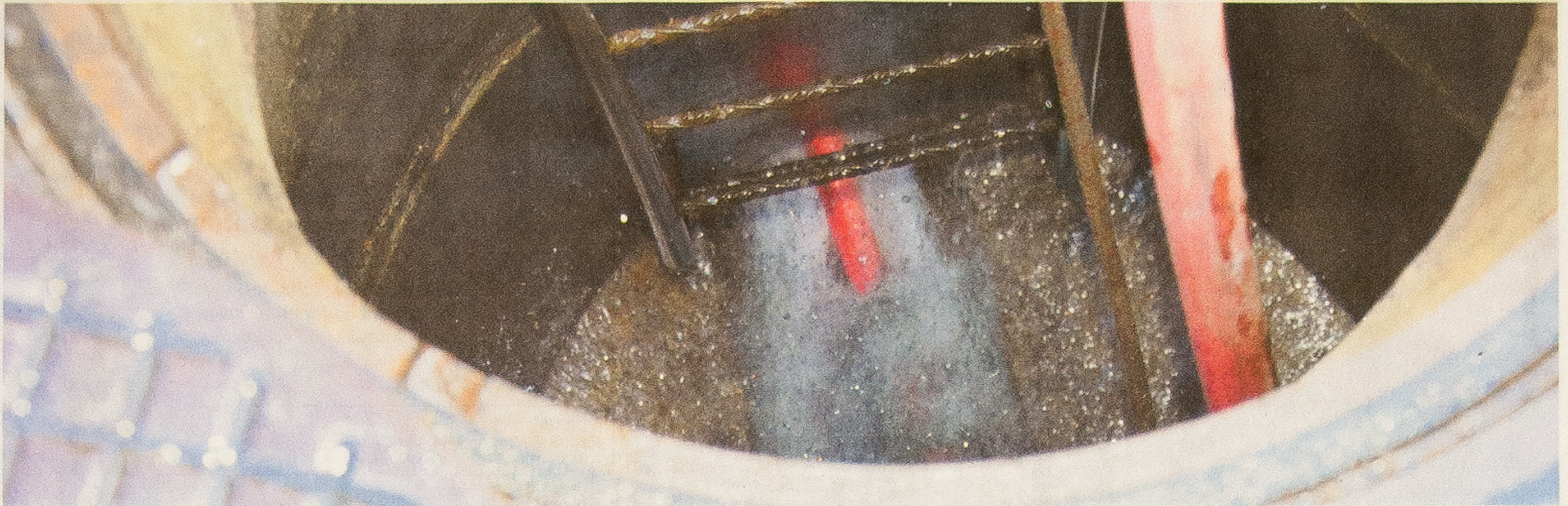
Die Kanalreiniger arbeiten nicht nur im Schacht mit Hochdruck.
