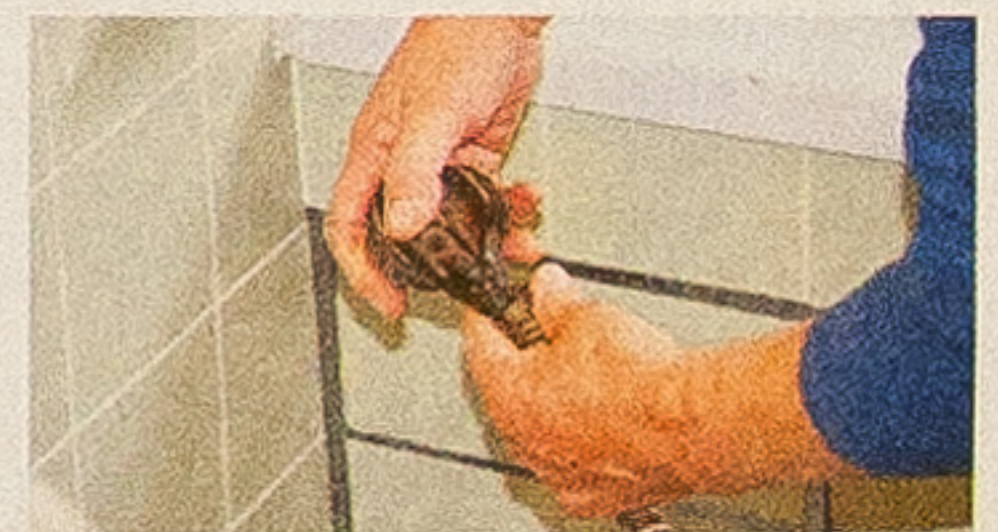
Hans Wälti montiert eine Stahlkugel, um die verstopfte Leitung freizubekommen.
