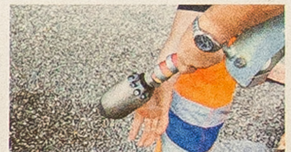
Sepp Büeler montiert die Düse für das Grobe in der Kanalspülung.
